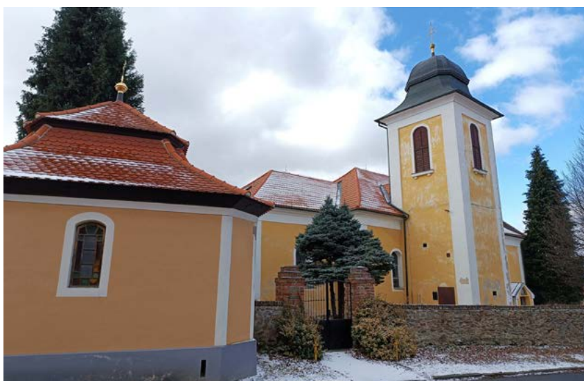
Malá budova sousedící se zdislavickým kostelem ukrývá unikátní kostnici
